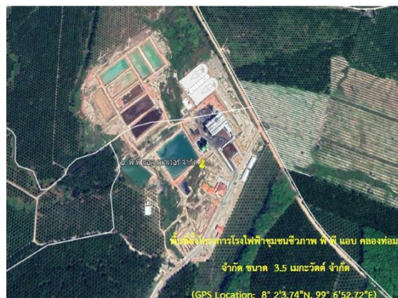
ที่ตั้งโครงการโรงไฟฟ้าชุมชนชีวภาพ พี พี แอล คลองท่อม เลขที่ 99/9 หมู่ที่ 2 ตำบลเพขลา อำเภอลองท่อม จังหวัดกระบี่ 81120 ขนาดพื้นที่โรงไฟฟ้าประมาณ 8 ไร่
