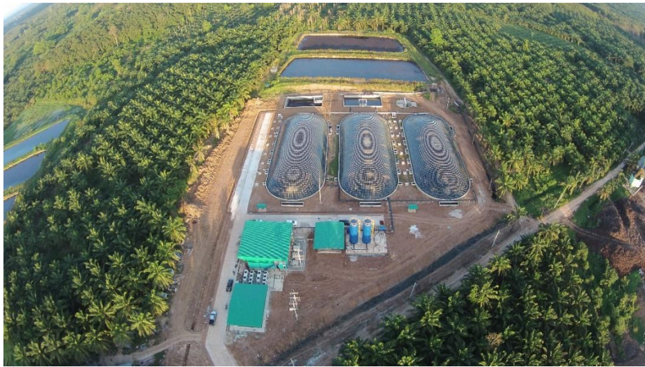
บ่อก๊าซชีวภาพ โรงไฟฟ้าพระแสง จังหวัดสุราษฎร์ธานี
