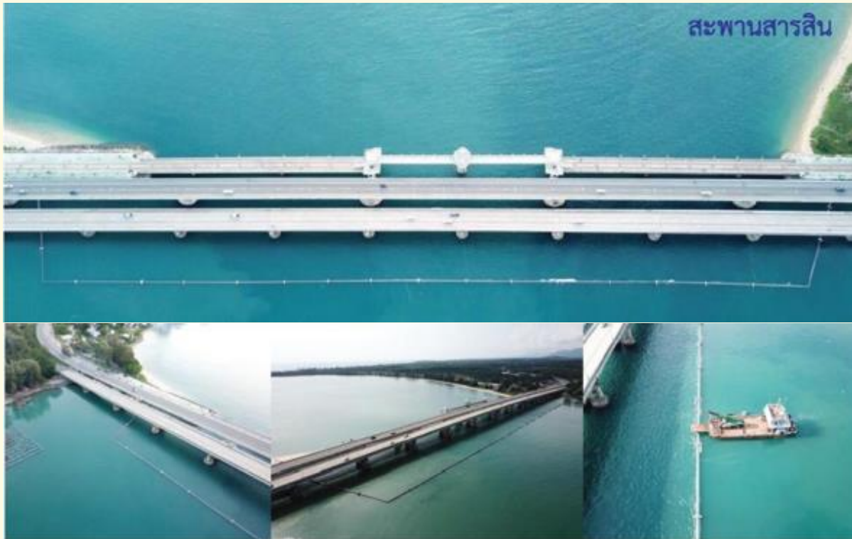
รูปภาพการต่อท่อน้ำประปาของ GS บริเวณสะพานสารสิน
